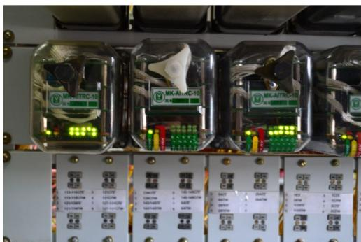
Все измерители выполнены в корпусе реле НМШ и устанавливаются на стандартных полках релейных стативов.
